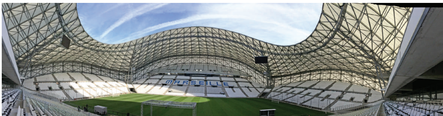
3. I lavori di rinnovo del Velodrome Stadium di Marsiglia
